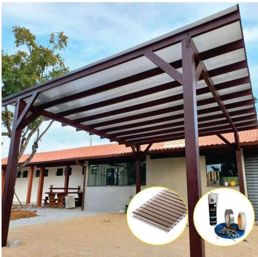
**Figura 3** - Imagem de cobertura de policarbonato já instalado em pergolado.
